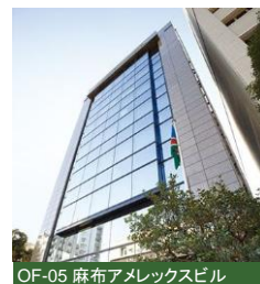
OF-05 麻布アレックスビル
