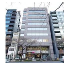
飛栄九段ビル
