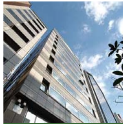
OF-02 NKビル
