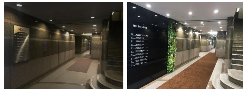
共用部の改修工事
