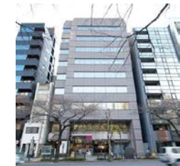
飛栄九段ビル
