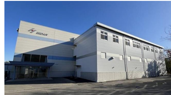
写真右側が増築個所2か所の内の1か所
