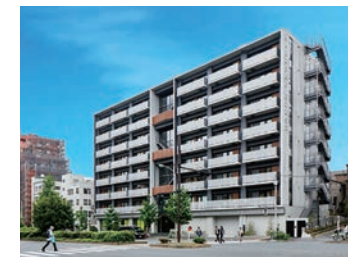
GSAスターアジア第1号開発案件 HAKUSAN HOUSE
