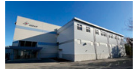
写真右側が増築箇所2か所の内の1か所
